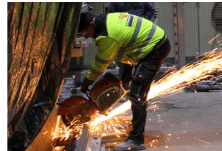
Mit Hilfe eines Trennschleifers werden die alten Fahrwerkschienen zersägt.
