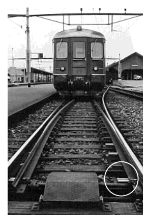
Die Gleitelemente sind schwalbenschwanzförmig ausgelegt. Schräg zur Gleitrichtung verlaufen Nuten, die Abrieb, Schmutz und Fremdkörper optimal abführen.
