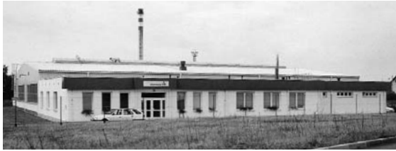
Das Gebäude von Ensinger, s.r.o. in Dobruška, Tschechien
