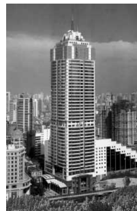
Das Nanzheng-Gebäude in Shanghai. Dort befindet sich das Repräsentanzbüro von ENSINGER.
